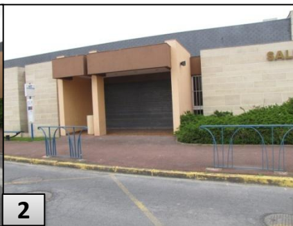
2 Entrée de la salle conforme
