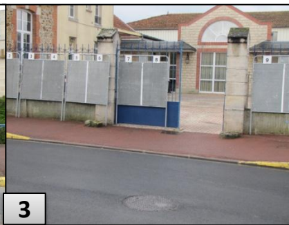
3 Entrée de la salle de réunion conforme – Faible ressaut sur trottoir
